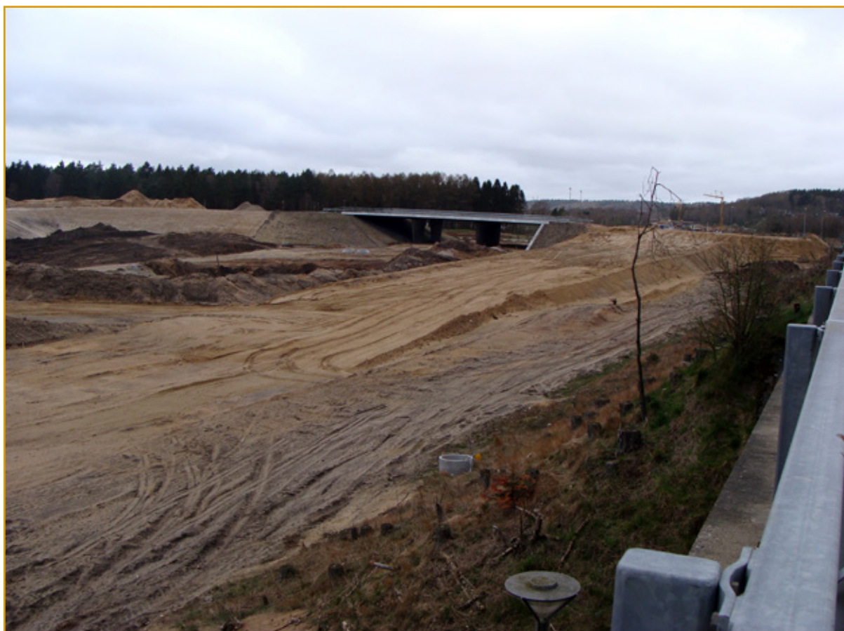
Motorvejsbyggeri ved Silkeborg, april 2014.
