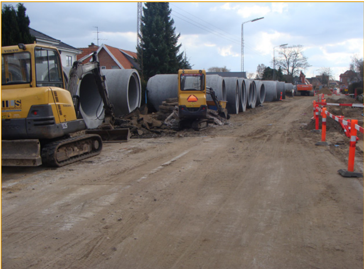
Renovering af vej og regnvandsledning, Viborg Kommune.
