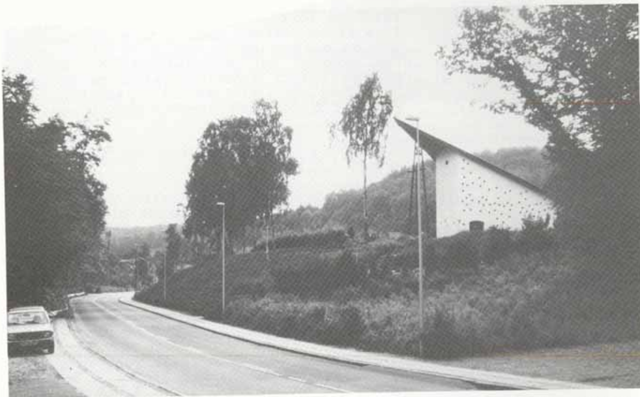
Moderne kirkearkitektur, tegnet af arkitekt J. Malling Pedersen, opført i 1959 på den vestlige dalkant i den smalle Grejsdal nord for købstaden Vejle.
